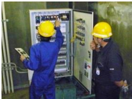
【設備保守点検作業】
