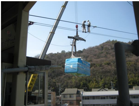
【客車更新作業】
